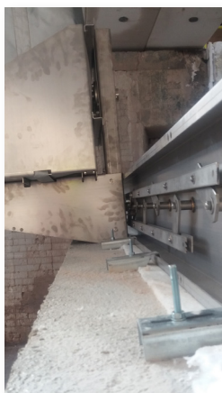
Gros plan étriers fixés et joint en fibres minérales
